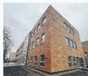
Rozbudowa SP Nr 3
