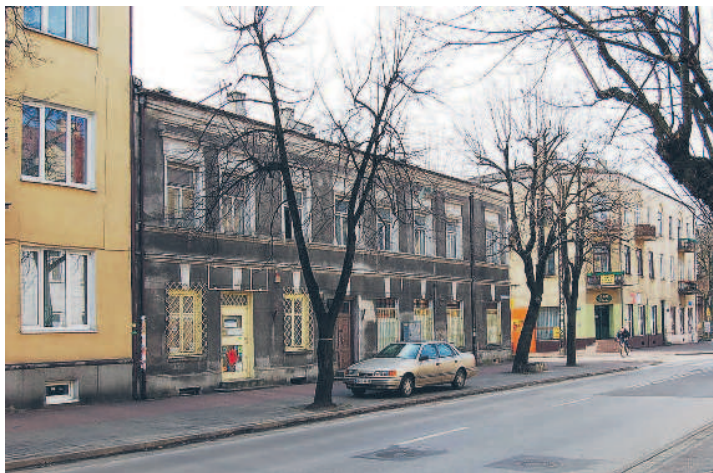
Nieistniejący (wyburzony w 2009 r.) budynek przy ul. Kościuszki 47, róg Daszyńskiego, w którym w okresie międzywojennym mieściła się biblioteka miejska, a do lat 80. jedna z filii. Drzewo i samochód częściowo zasłaniają wejście. Zdjęcie z 2002 roku.
