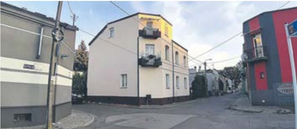
Wszystkie trzy narożne domy przy tym skrzyżowaniu miały kiedyś narożne wejścia, po których dziś nie ma śladu.
